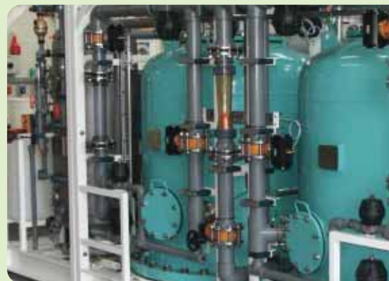
Planta desaladora de ósmosis inversa de 100 m 3 /día instalada en la nave HMS Illustrious, portaaviones de la Royal Navy británica.
